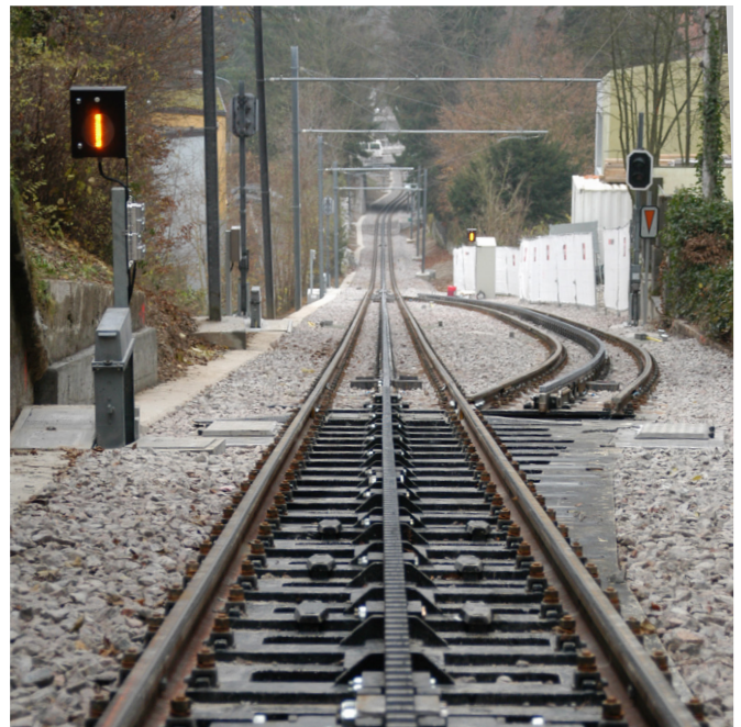
Auf der 1'328 Meter langen Strecke hat die Dolderbahn eine Höhendifferenz von 162 Metern zu überwinden; das entspricht einer Steigung von rund 19 Prozent.
