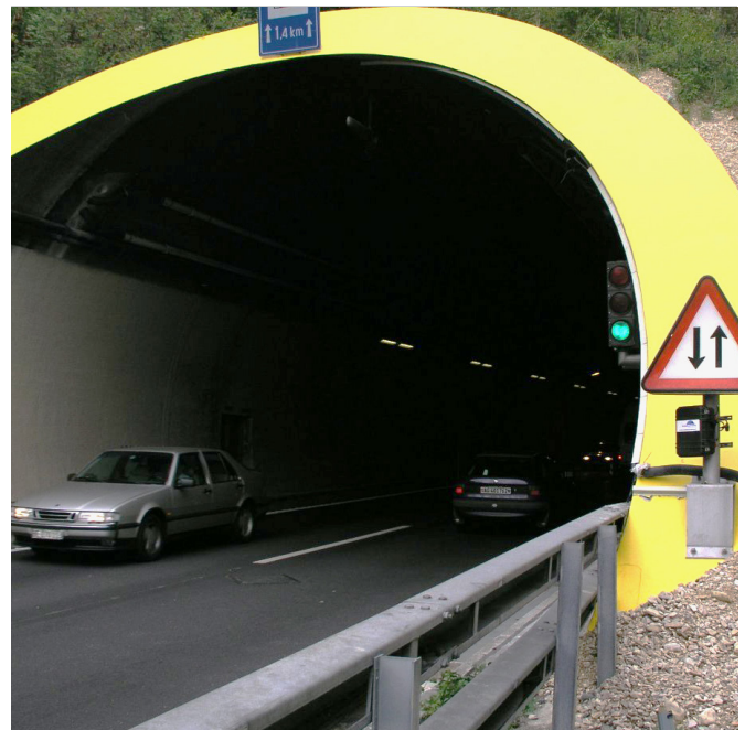
Die vielfältigen Einsatzmöglichkeiten des Flexilog erlaubten die Montage des Geräts direkt vor dem Tunnelportal. So konnten die Geschwindigkeiten genau da gemessen werden, wo sie für die Auswertungen wichtig waren.
