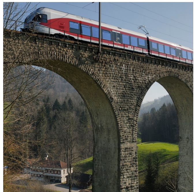
Die Schweizerische Südostbahn AG ist eine normalspurige Eisenbahngesellschaft in der Schweiz mit Sitz in St. Gallen. Im Bild: FLIRT-Komposition auf dem Waldbachviadukt.
